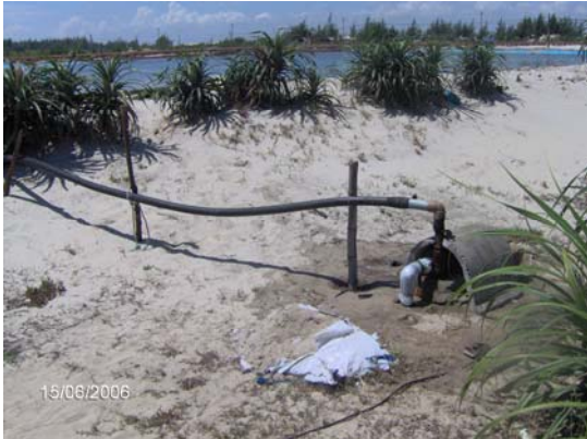
Hình 1. Khai thác nước dưới đất bằng giếng khoan.
